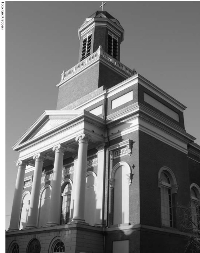
Kerk met "dichtgemetselde kelder".
