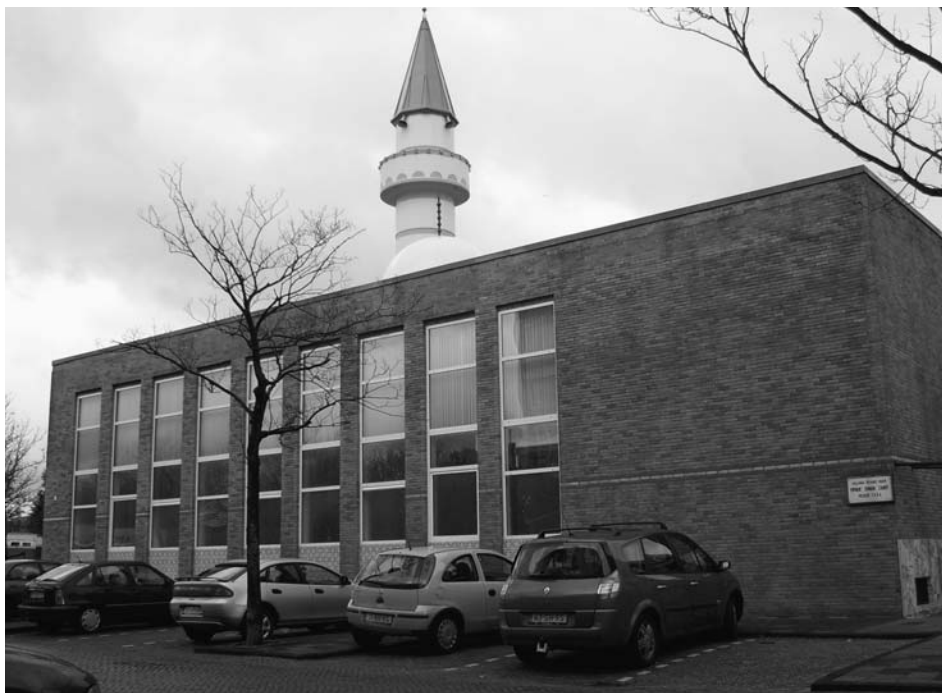
Moskee waarvan de kelder nog moet worden "dichtgemetseld".
