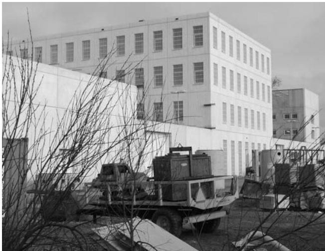
Alphense illegalenbajes in aanbouw.
