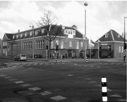
Grijzen Wolven-bolwerk aan de Zeeburgerdijk in Amsterdam.
